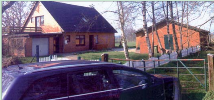
Die Gebäude der neuen Station
